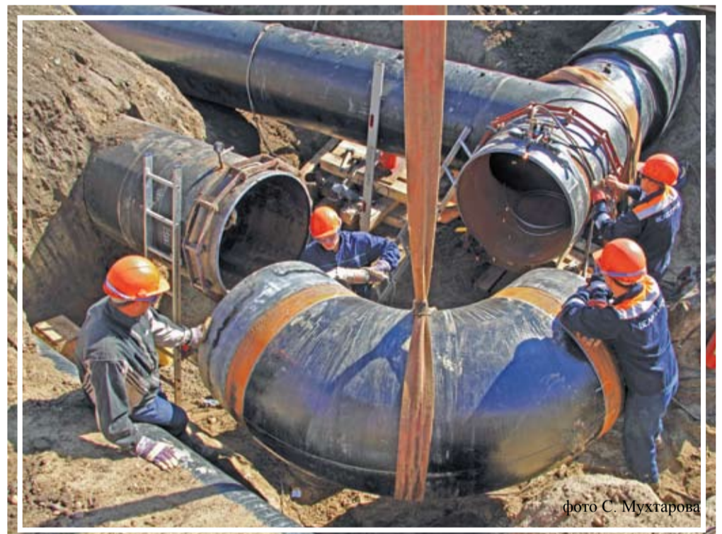
Монтаж узлов обвязки магистральной насосной, НПС «Кропоткинская»
