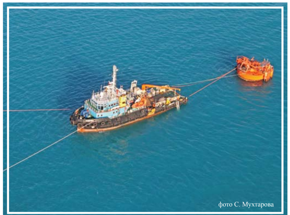
Проведение работ по замене подводных шлангов ВПУ, акватория Морского терминала
