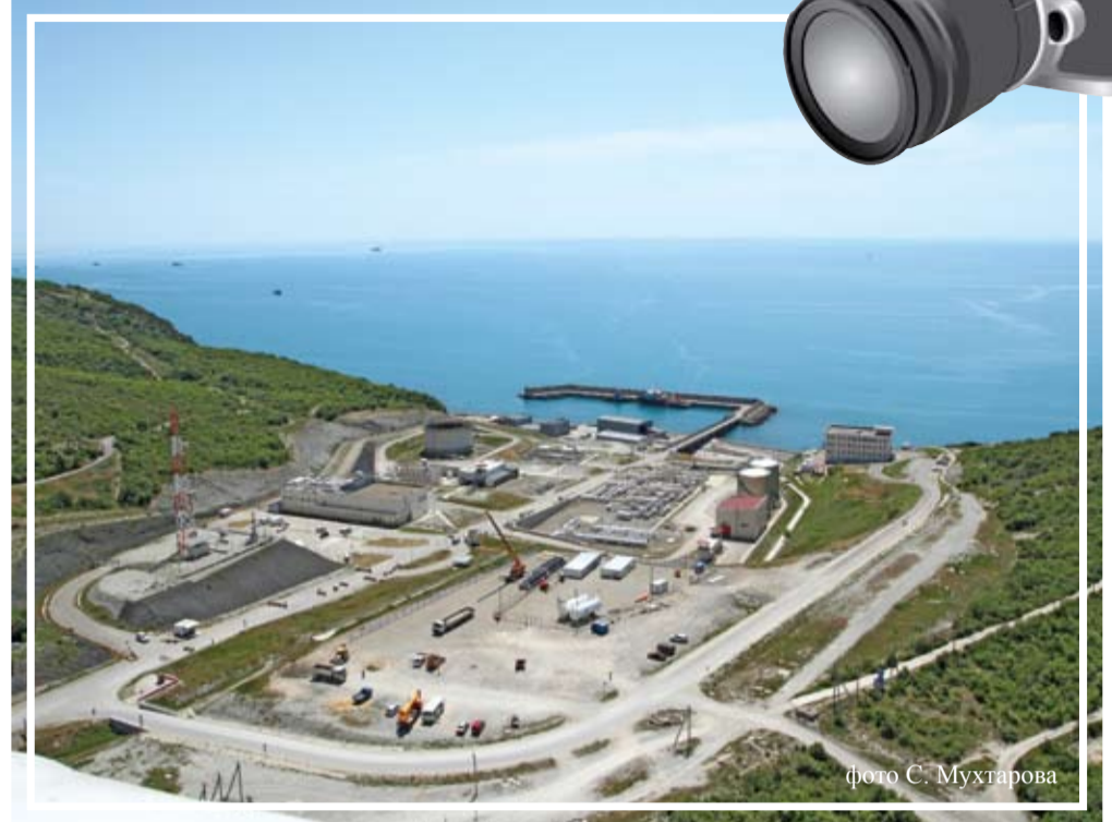
Береговые сооружения Морского терминала
