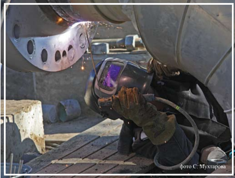
Сварочные работы в процессе замены шаровых кранов, НПС «Кропоткинская»
