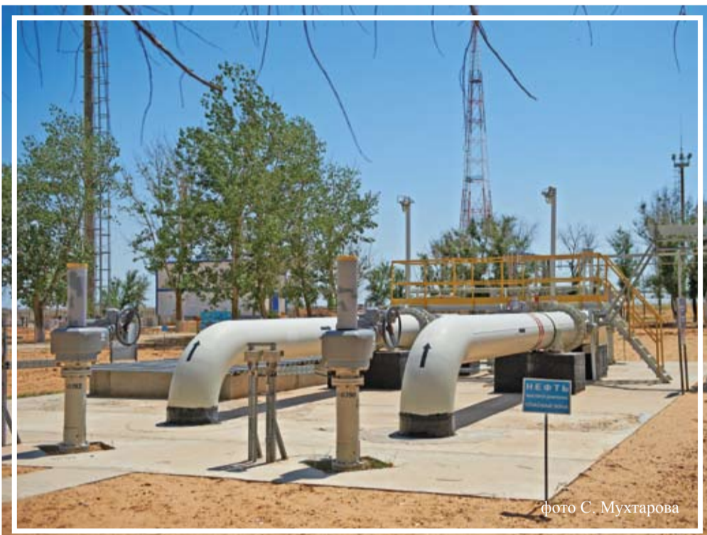
Узел регулирования давления на выходе, НПС «Астраханская»
