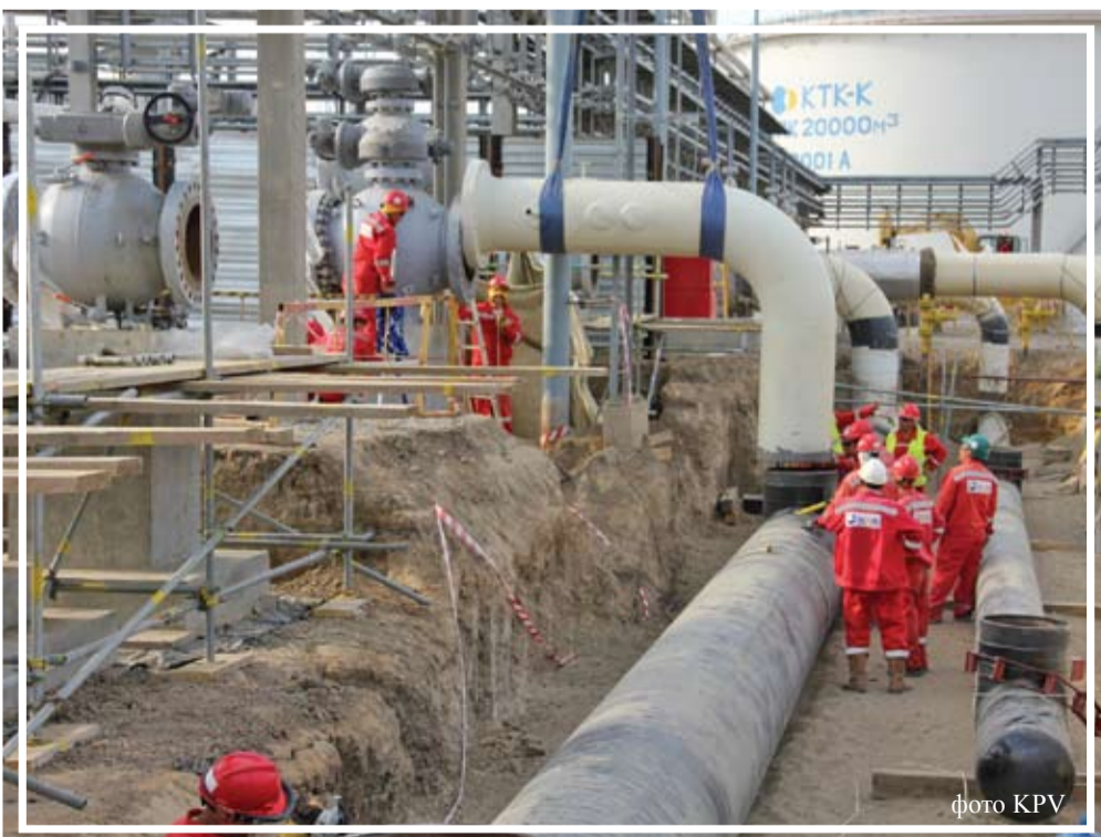
Монтаж узлов обвязки магистральной насосной, НПС «Атырау»
