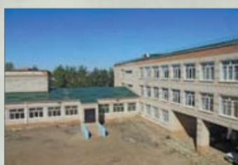
Важной частью благотворительной программы КТК в рамках Проекта расширения стал капитальный ремонт средней школы в селе Енотаевка (Астраханская область). Консорциум выделил на эти цели более 30 млн руб. В здании заменены кровля и система отопления, установлены новые стеклопакеты, проведен монтаж освещения и вентиляции спортзала. Кроме того, в рамках дополнительного соглашения к договору в школе установлен новый тепловой узел.
