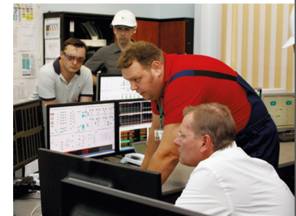
В операторной НПС «Астраханская»
