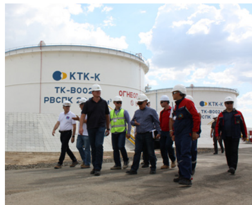
Осмотр НПС «Атырау»
