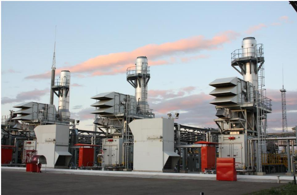
При строительстве новых и модернизации магистральных насосов старой группы в КТК на А-НПС-4А, НПС «Комсомольская» и НПС «Кропоткинская» были заменены турбинные двигатели со старой системой сжигания топлива (MPI) на турбинные двигатели с системой сжигания топлива DLE (Dry Low Emission – сухое подавление выбросов), которая обеспечивает в 3 раза меньшие выбросы по оксидам азота (NO<sub>x</sub>).
