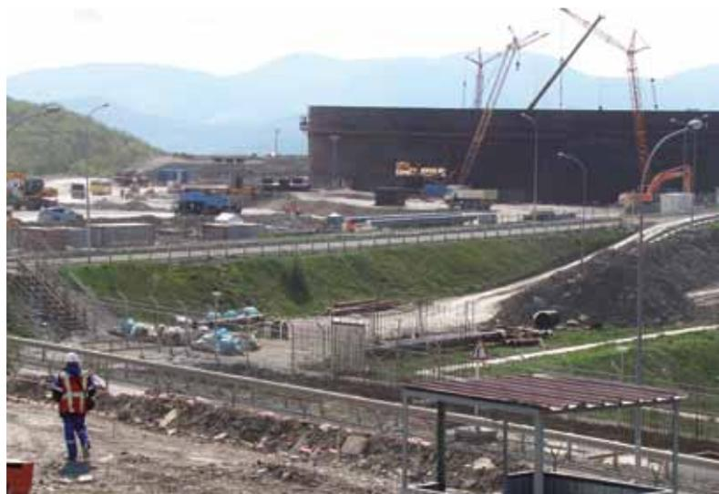
Уже готовы фундаменты под мачты молниеотводов (по три на резервуарах № 8 и 4 и один – на № 6). С середины мая подрядчики приступят к монтажу металлоконструкций самих молниеотводов.
