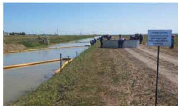
Развертывание бонов и установка резервуара временного хранения нефти
