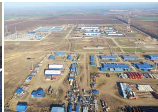
Вид на строящуюся НПС-7. Все начиналось с землеотвода...
