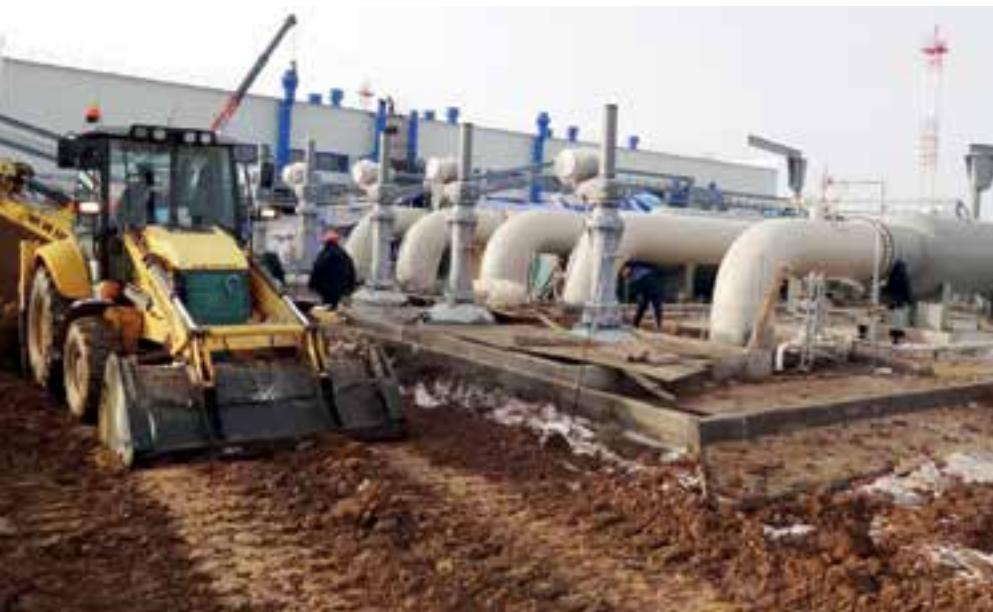
Обустройство площадки ФГУ на НПС-4
