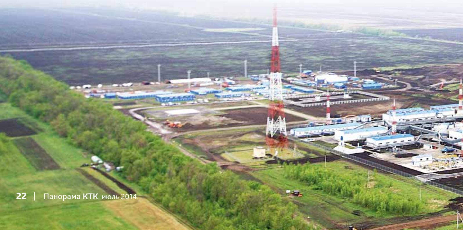
строителям довелось решать проблему высокого залегания грунтовых вод, для чего здесь полностью поменяли вертикальную планировку и усовершенствовали фундаменты.
