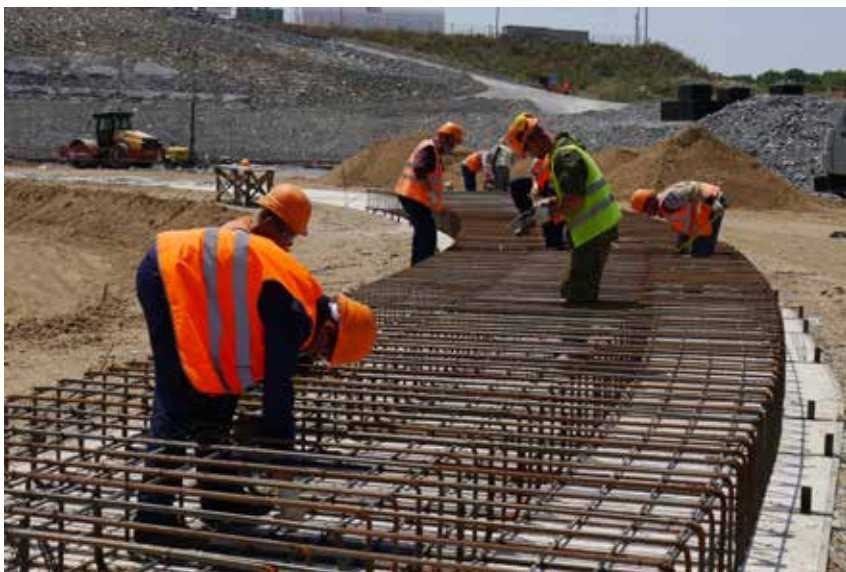
Армирование фундамента резервуара
