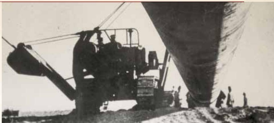
При прокладке магистрали впервые использовались специально разработанные Владимиром Шуховым петли трубопровода, что позволило значительно повысить его пропускную способность. Соединение труб осуществлялось газовой и электродуговой сваркой электродами с меловой обмазкой.
