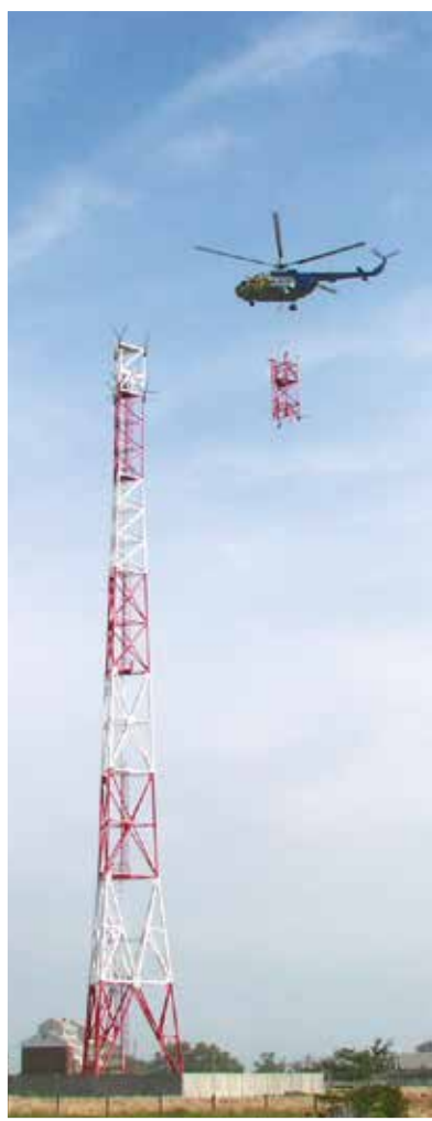
Монтаж вышки радиорелейной связи на НПС «Кропоткинская» (Россия)
