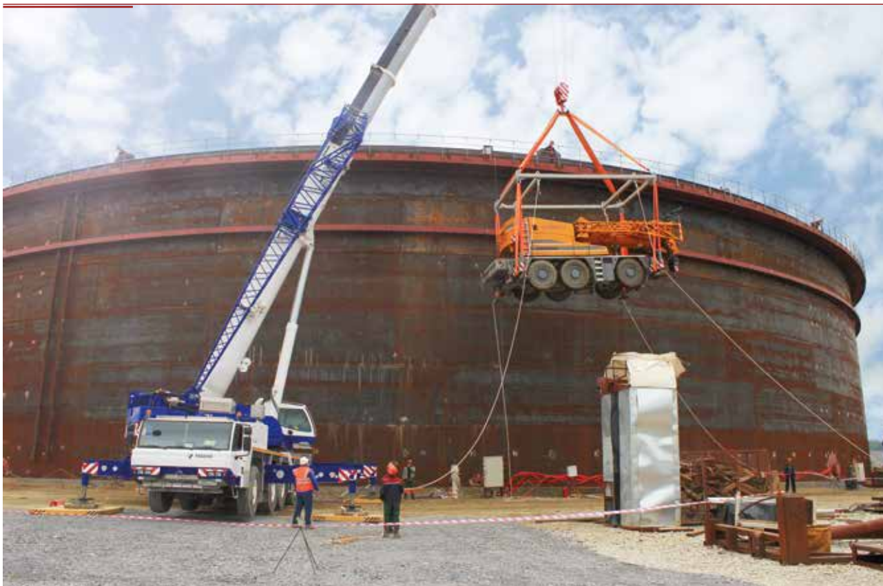
Впервые в России краны извлекали из резервуаров-стотысячников с высотой стенки свыше 20 м
