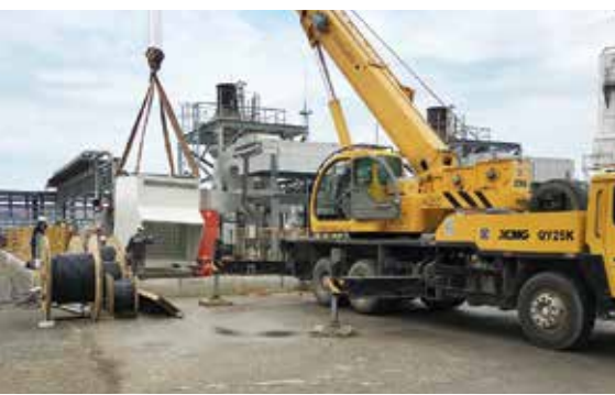
Майсуытқыш корпусын монтаждау
