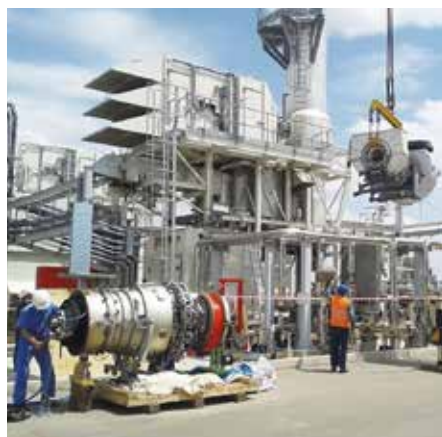
Қолданыстағы турбинаны ауыстырып, жаңасын қоюға дайындық
