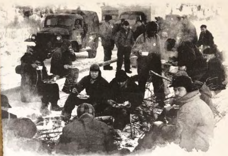
Строительство трубопровода пришлось вести при температурах до -60^{\circ}\text{C}
