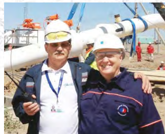
Ремонтные работы по реконструкции узла пуска скребка в Казахстане. А. В. Савин с руководителем Атырауского филиала ООО «Старстрой» И. В. Штином. 2010 год
