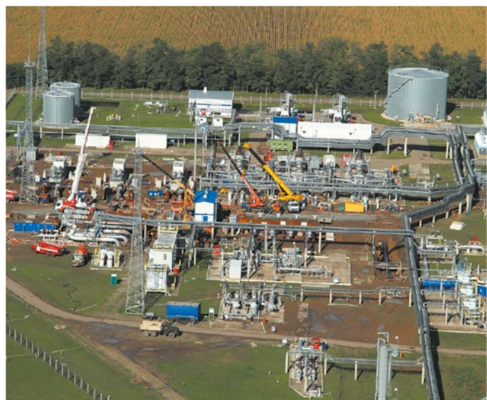
Модернизация НПС «Кропоткинская». Август 2012 г.
