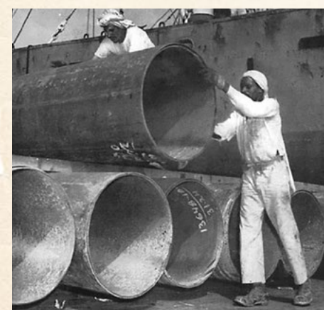
При транспортировке на судах в трубы большего диаметра помещали трубы меньшего
