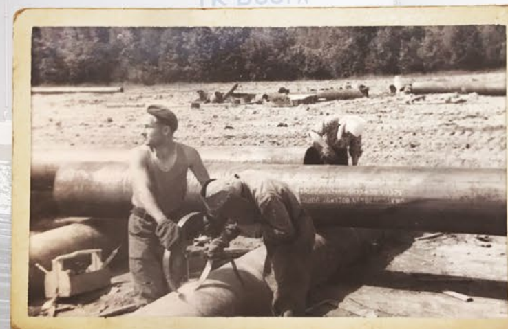
Трубоплавильная база. Укладка трубопровода. 60-е годы. Актюбинская область
