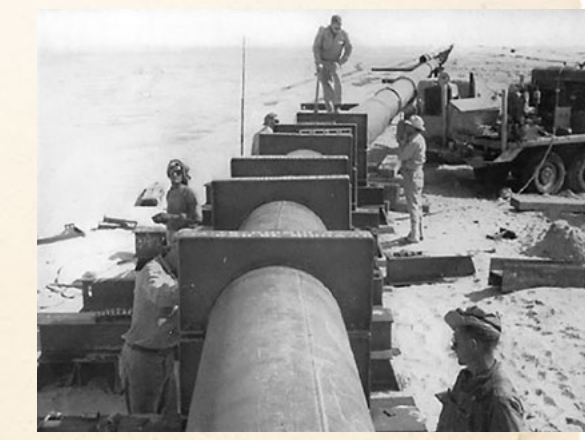
В Саудовской Аравии участок нефтепровода монтировали на специальных опорах
