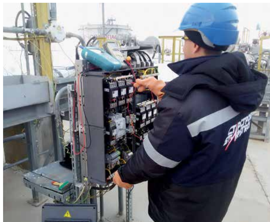
ПЕРСОНАЛ ООО «СТАРСТРОЙ» ВЫПОЛНЯЕТ НА ОБЪЕКТАХ КТК ЗАДАЧИ ЛЮБОЙ СЛОЖНОСТИ
