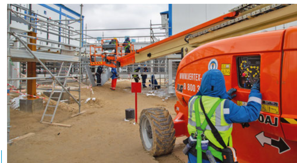
МОНТАЖ ЧРП НА НПС «ТЕНГИЗ»
