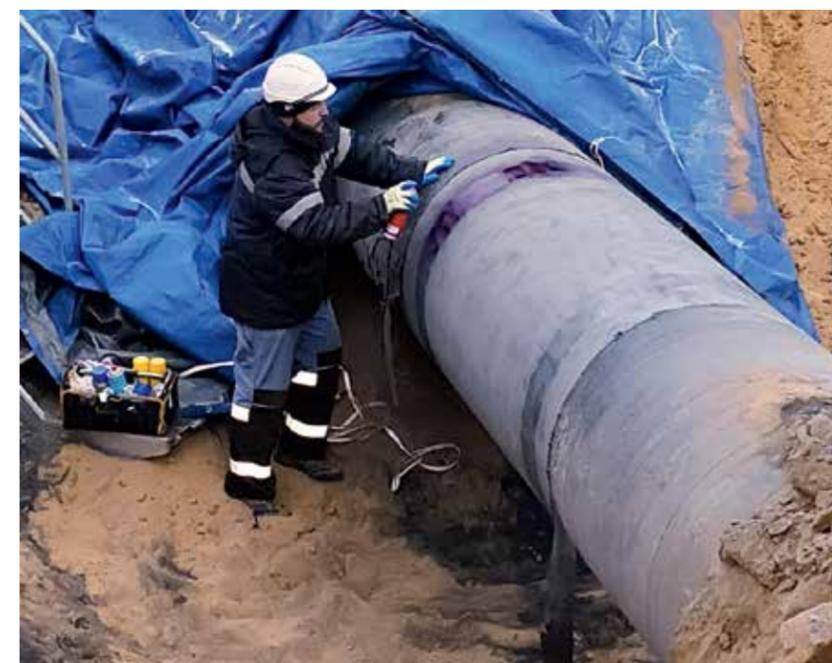
КАПИЛЛЯРНЫЙ КОНТРОЛЬ ОСНОВНОГО МЕТАЛЛА В МЕСТАХ ПРИВАРКИ КОЛЬЦЕВЫХ СТЫКОВ РЕМОНТНОЙ КОНСТРУКЦИИ П2
