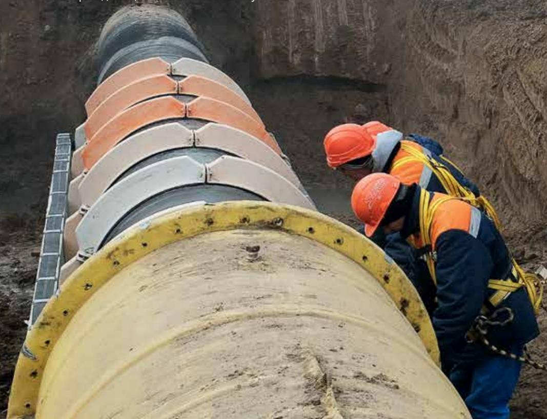
Так что же они делают на магистральном нефтепроводе Тенгиз — Новороссийск? Со скоростью 12 м в неделю подрядчики устанавливают специальный защитный футляр 100-метровой длины, после чего внутреннее пространство между футляром и трубопроводом будет заполнено специальным синтетическим гидрофобным гелем. Кто-то скажет, что это совсем не быстро, но будет неправ.
