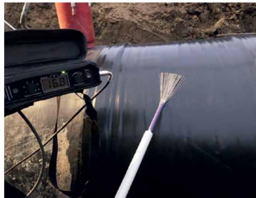
ПРОВЕРКА КАЧЕСТВА ИЗОЛЯЦИОННОГО ПОКРЫТИЯ НА 1216-М КМ
