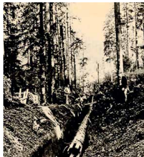
УКЛАДКА ДЕРЕВЯННОГО ТРУБОПРОВОДА ВБЛИЗИ АСТОРИИ (ОРЕГОН), 1884 ГОД
