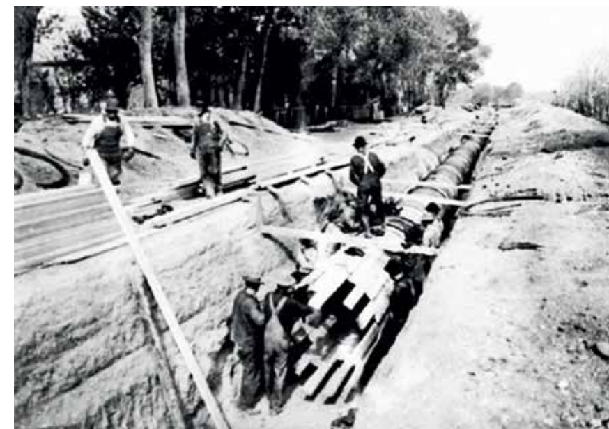
УКЛАДКА 48-ДУЙМОВОГО ДЕРЕВЯННОГО ТРУБОПРОВОДА В ДЕНВЕРЕ (КОЛОРАДО), 1910 ГОД
