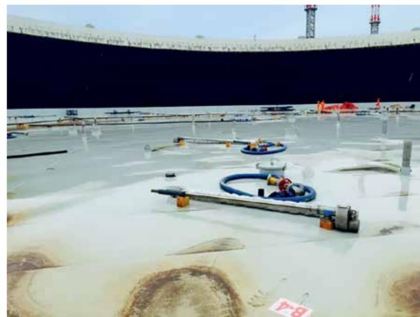
ПОДГОТОВКА К РАЗМЫВУ. НА ПЕРЕДНЕМ ПЛАНЕ – ПОВОРОТНАЯ РАЗМЫВАЮЩАЯ ГОЛОВКА
